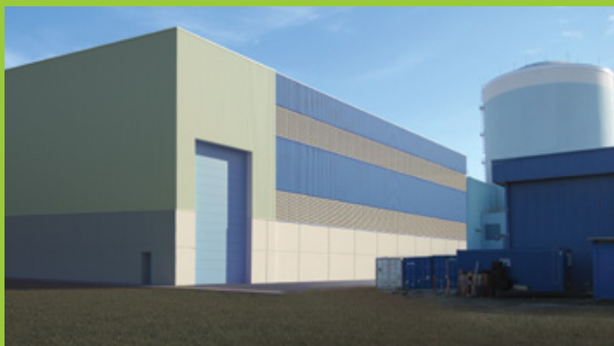
Zgrada suhog skladišta, NE Krško
