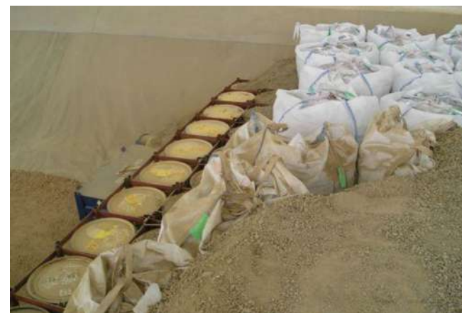
Površinsko odlagalište za vrlo nisko radioaktivni otpad
